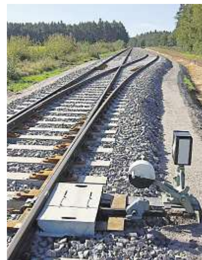
Der Schotter wird auch für die Gleise verwendet.
