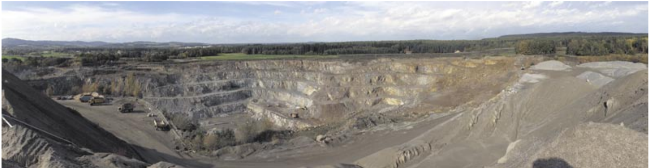
Seit 1971 verfeinert Schwinger in Nittenau den Abbruch von Diorit und Granit.
